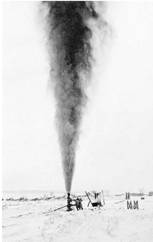
Первая рабочая газовая вышка, Елшанское газовое месторождение
