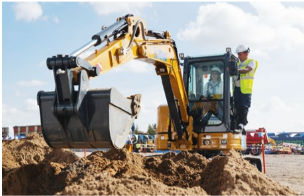
Фото: АО «Газстройпром»
