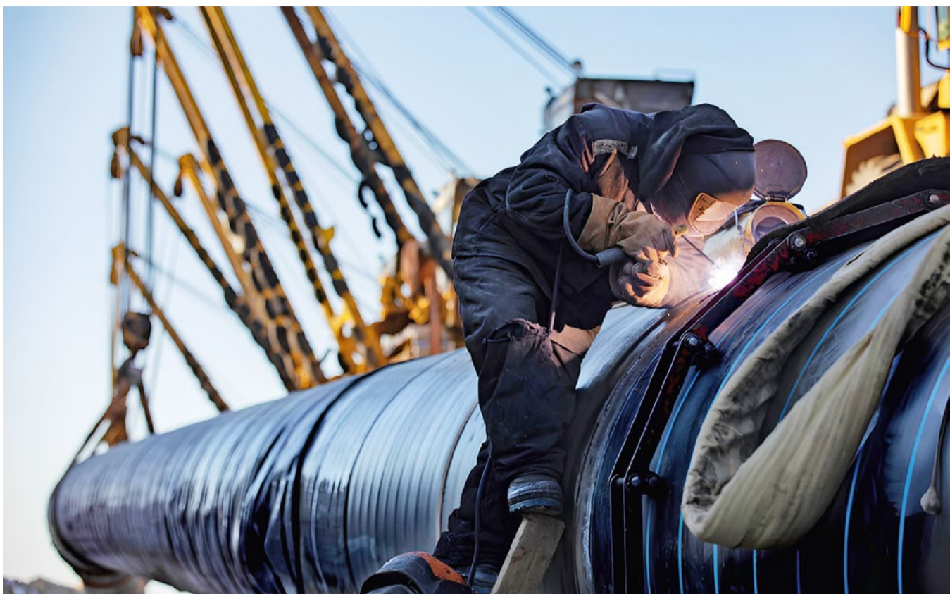
Фото: АО «Газстройпром»
