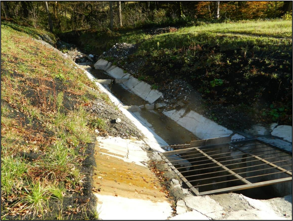
Рисунок 18 - Балка, забранная в лоток. Т.н. 27
