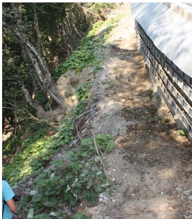
Фото 21. Склон ниже СТ-70/1 – крутой с наклонившимися деревьями
