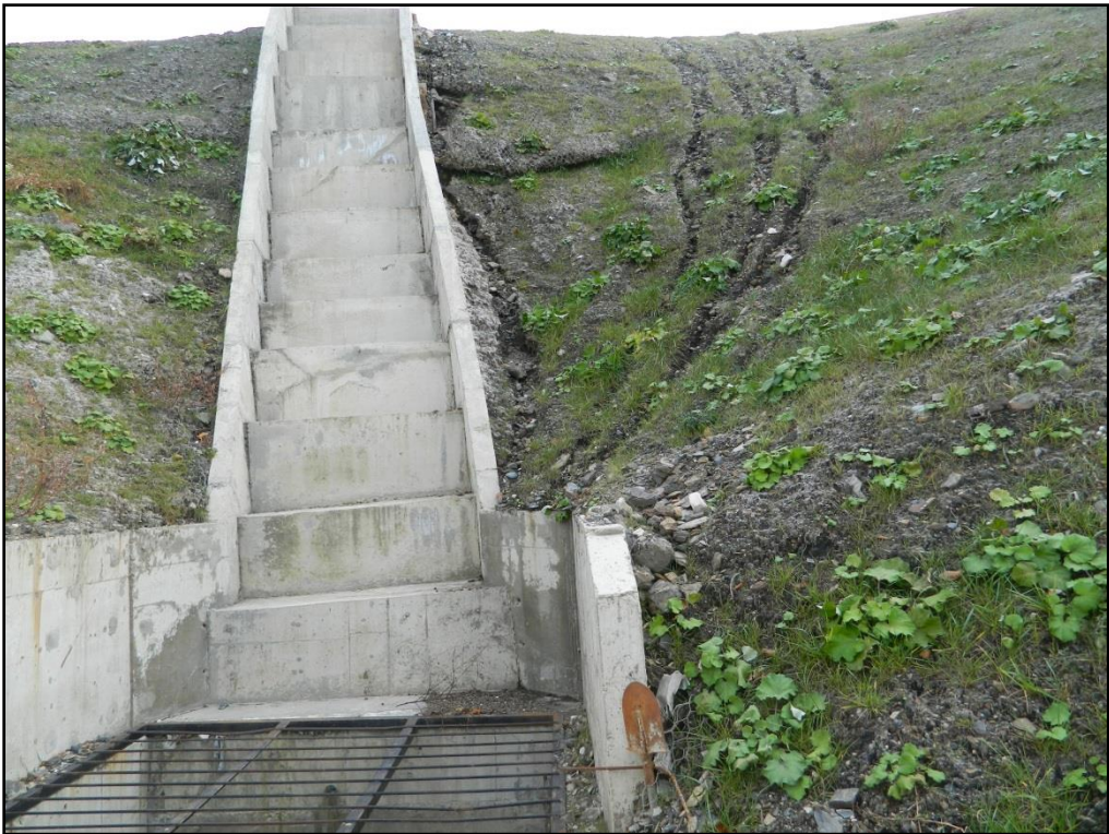
Рисунок 10 - Развитие эрозионных и оползневых процессов. Т.н. 630
