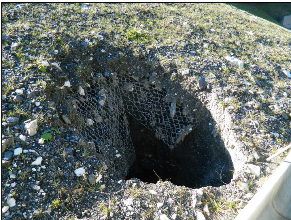
Рисунок 14 - Суффозионная воронка. Т.н. 268
