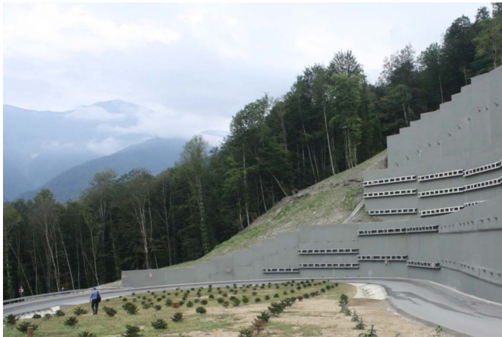
Фото 5. Склон за СТ-7 – крутой, сложен насыпными грунтами, засеян травой
