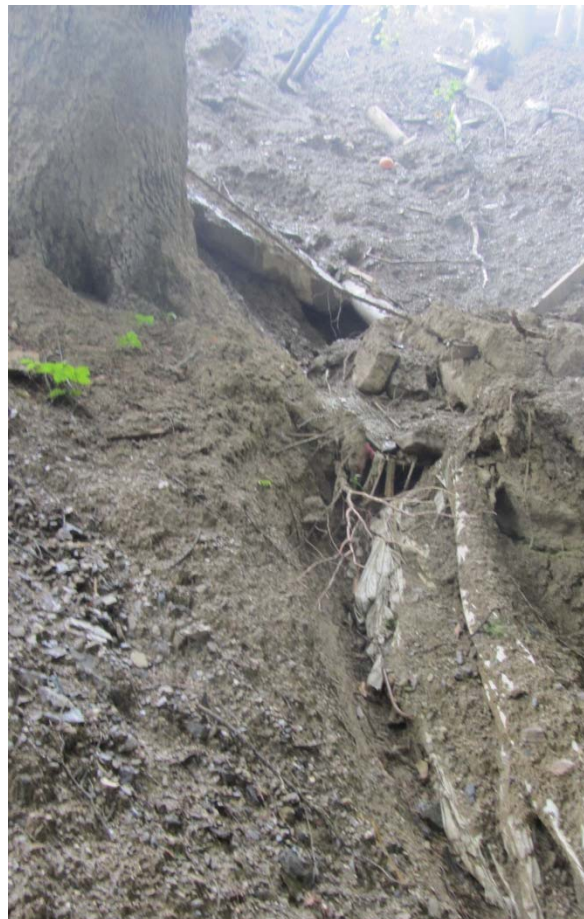
Фото 31. Грунт, деревья и строительный мусор вовлечены в процесс сползания
