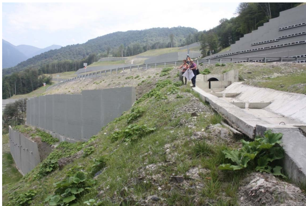
Фото 13. Водоотводной лоток вниз от СТ-15
