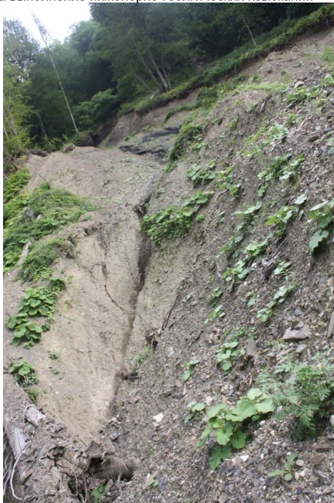
Фото 17. Высота пораженного склона по визуальному описанию достигает 40 м, протяженность вокруг дороги около 120 м, крутизна склонов достигает 60°, глубина ниже стенок отрыва оползневых блоков до 4-6 м
