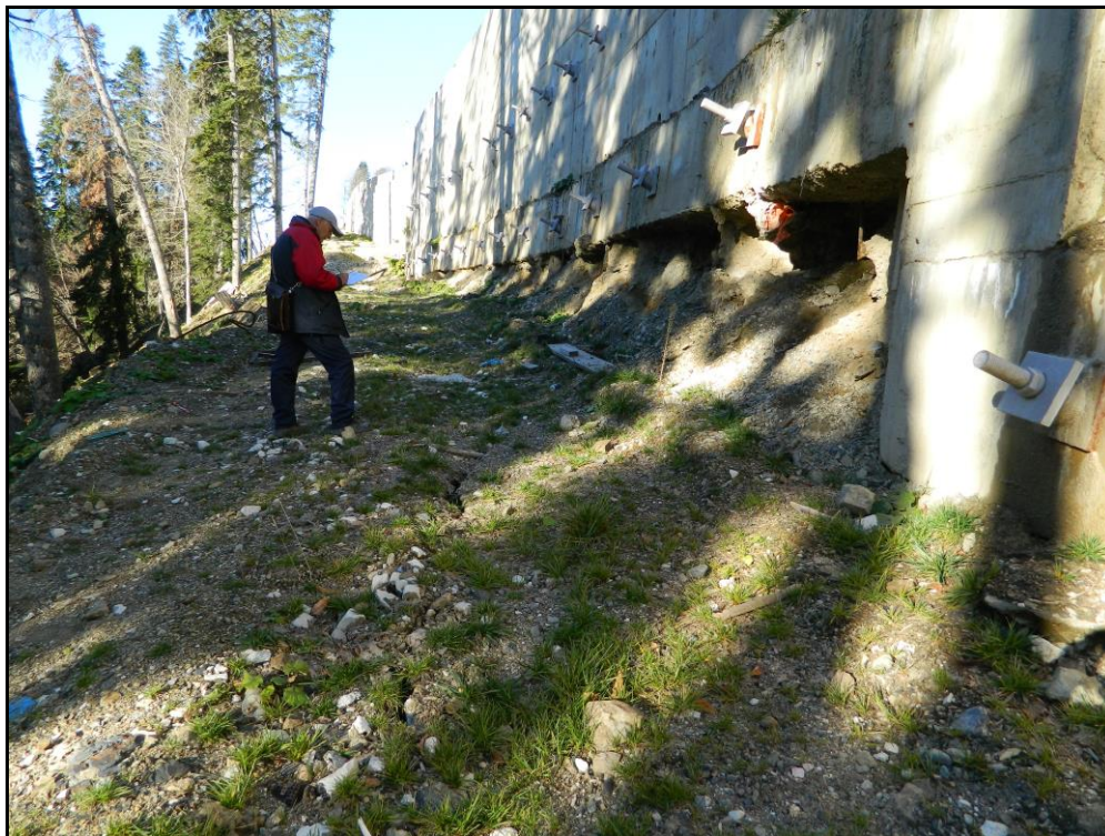
Фото 41. Обнажение фундамента подпорной стены. Т.Н.47.
