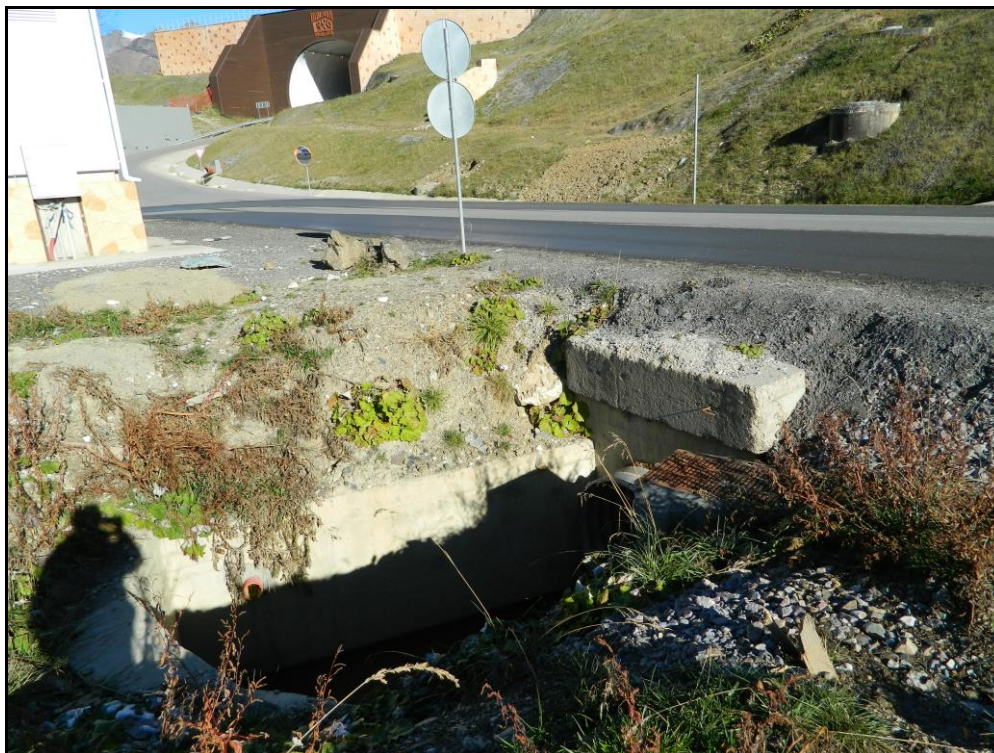
Фото 52. Спланированная площадка. Водопропускные сооружения. Т.Н.61.
