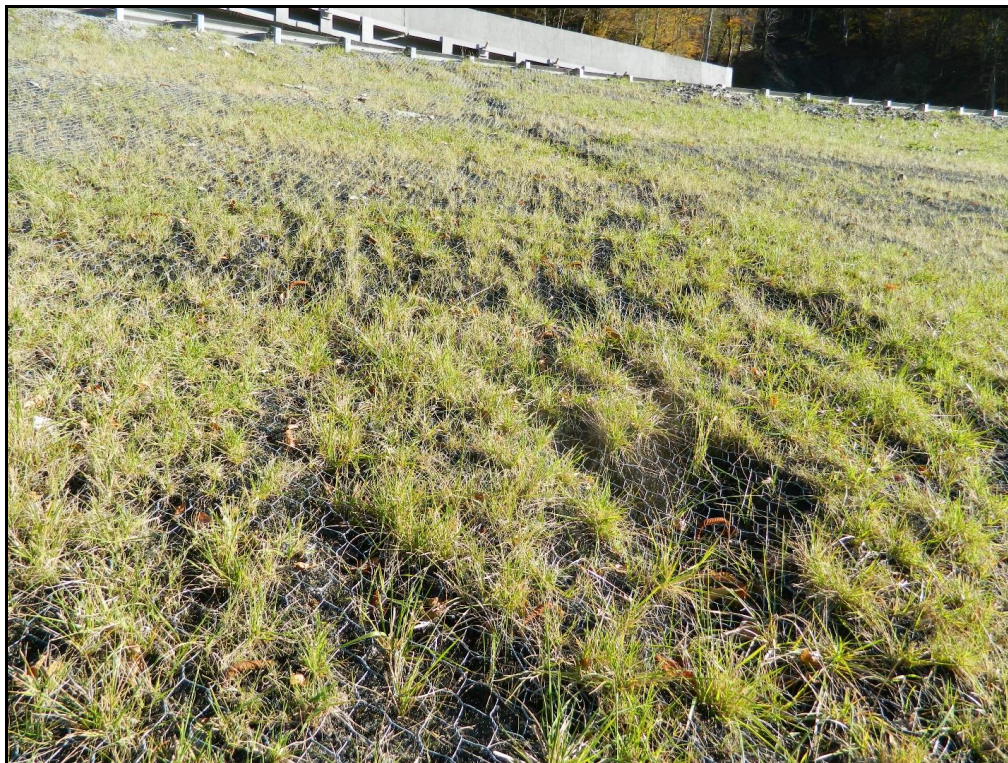
Фото 14. Эрозионный склон. Т.Н.15.
