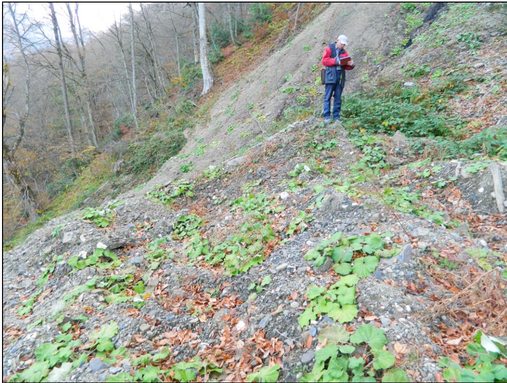
Фото 130. Оползневое тело. Т.Н. 578.
