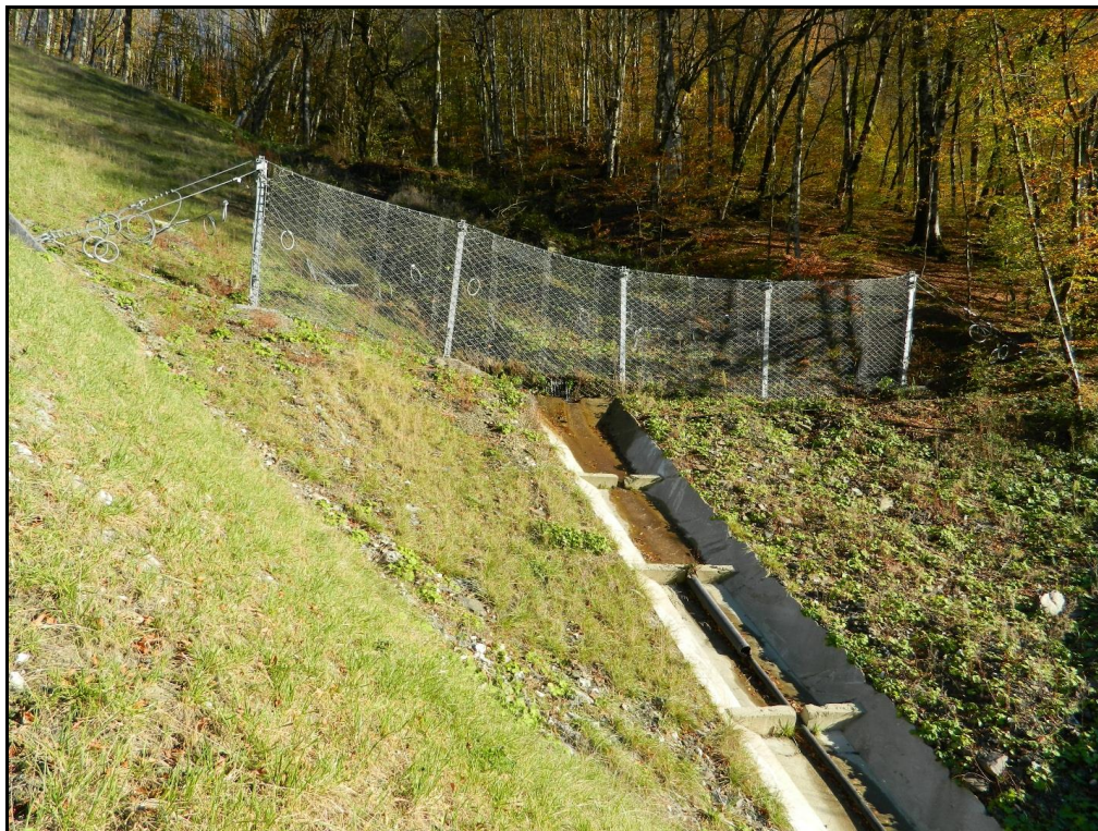
Фото 24. Балка в водопропускном сооружении с защитной сеткой. Т.Н.27.
