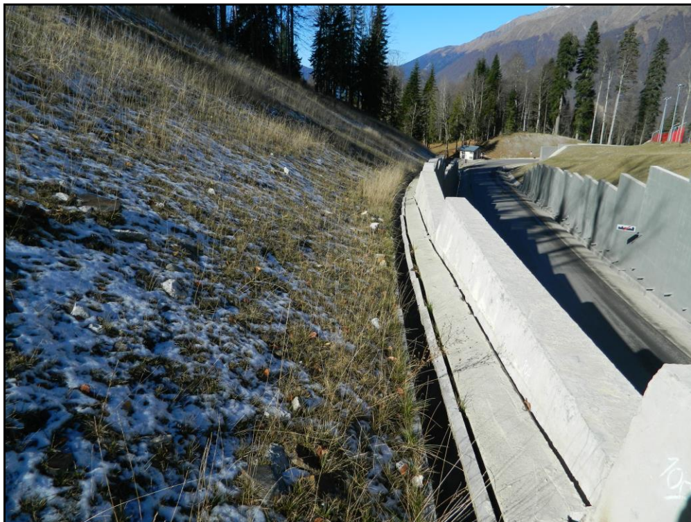
Фото 64. Водопропускной лоток. Т.Н.89.
