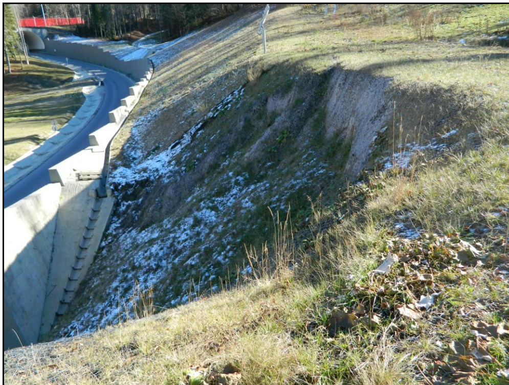
Фото 69. Процессы осыпания склона. Т.Н.110.
