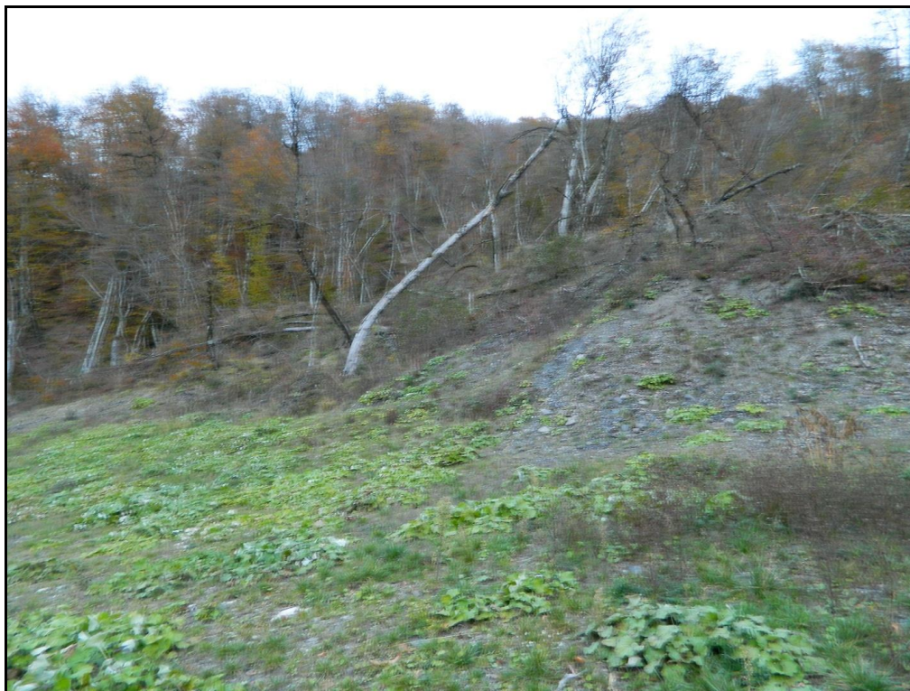
Фото 35. Оползневой склон. «Пьяный» лес. Т.Н.40.
