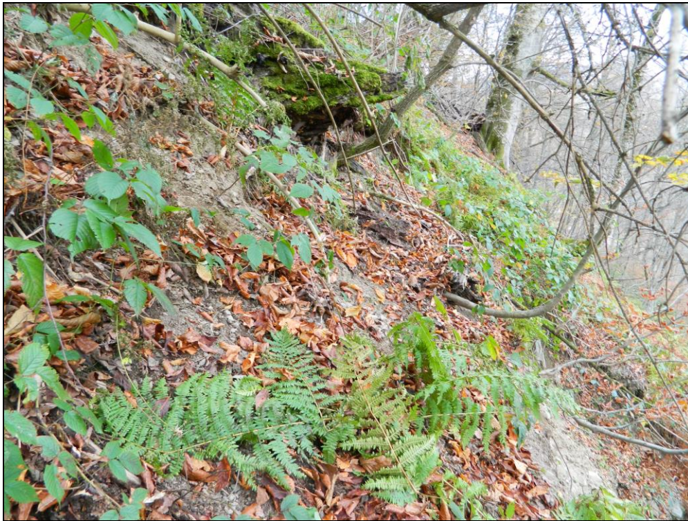
Фото 133. Оползневой склон. Т.Н. 587.
