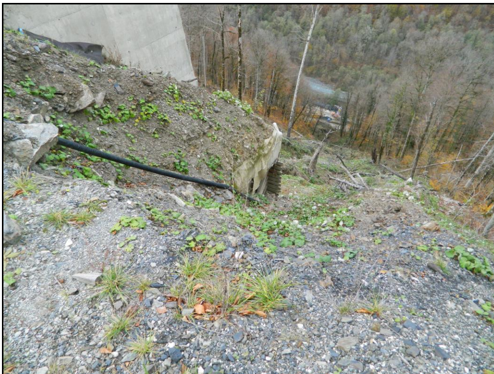
Фото 154. Обнажен фундамент стены. Т.Н.702.
