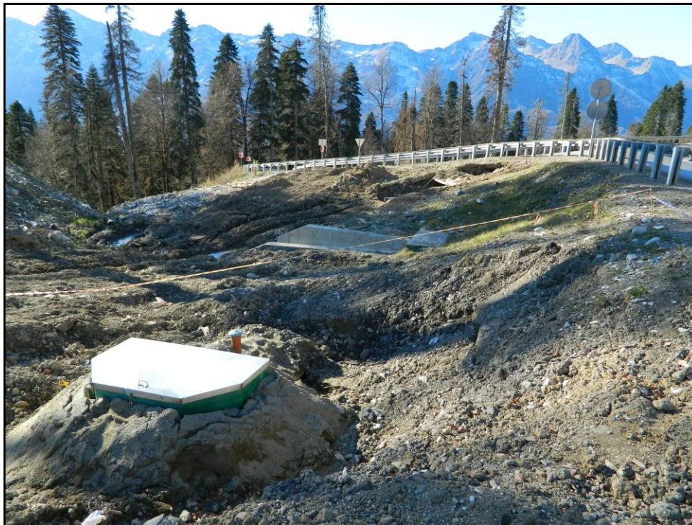
Фото 53. Изрытая площадка. Т.Н.62.
