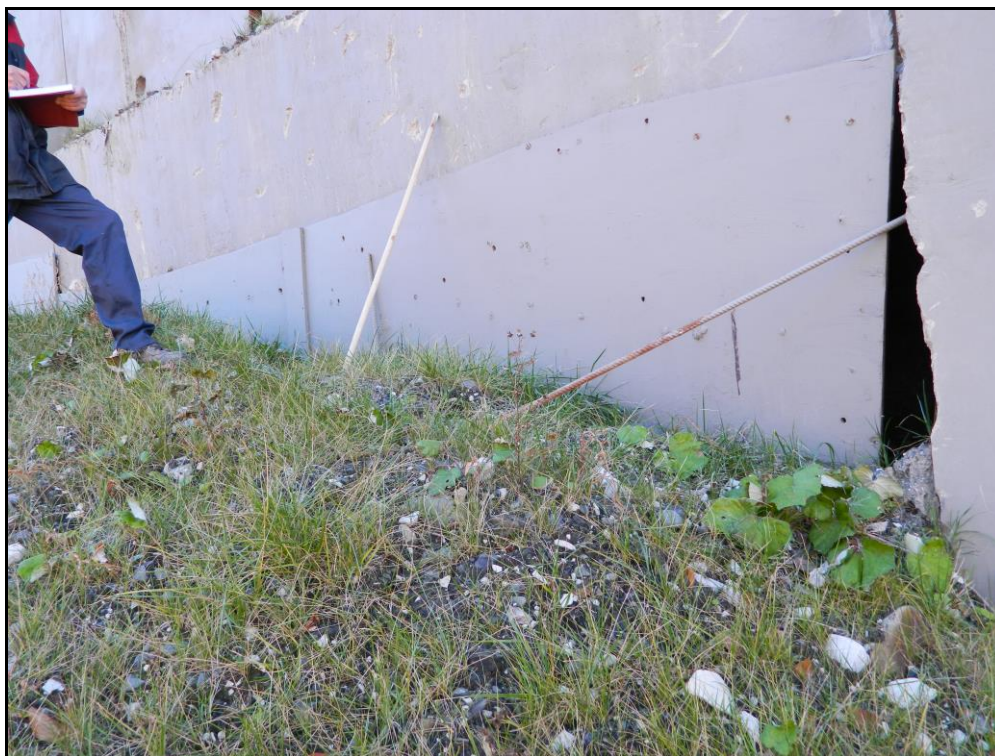
Фото 90. Обнажение фундамента в основании стены, закрытое фанерой. Т.Н.249.
