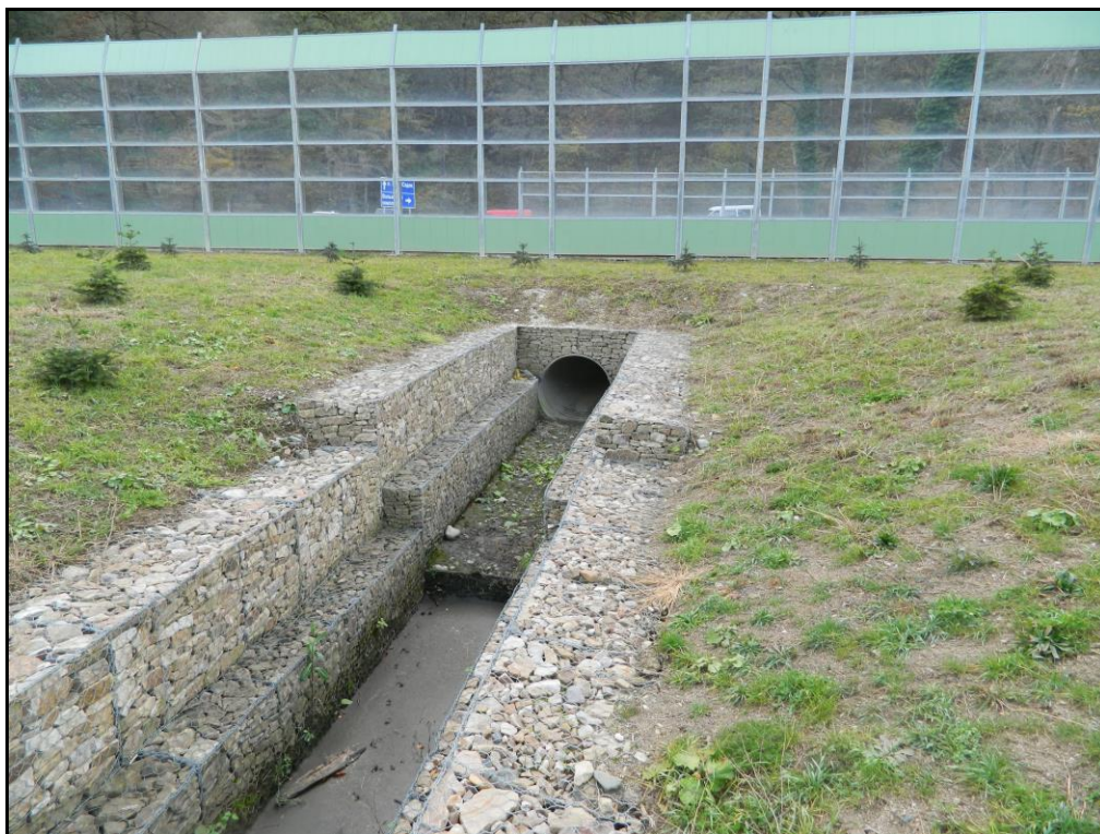
Фото 164. Спланированная терраса реки Лаура. Водопропускные сооружения Т.Н. 780.
