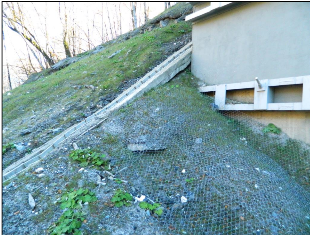
Фото 97. Осыпи и обвалы по кромке подрезки, развитие эрозионных процессов на склоне. Т.Н.288.
