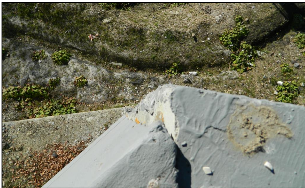
Фото 73. Фундамент СТ 48. Т.Н.135.
