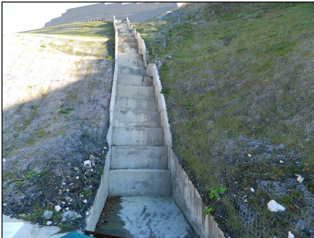
Фото 20. Балка в водопропускном сооружении. Т.Н.22.
