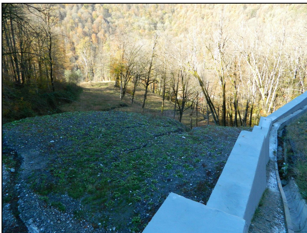
Фото 10. Эрозия в техногенных отвалах. Т.Н. 11.
