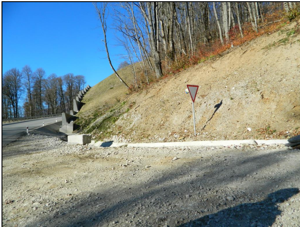
Фото 77. Осыпные и оползневые проявления Т.Н.154.
