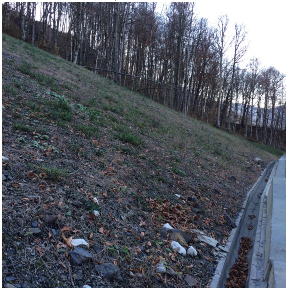
Фото 81. Склон спланированный, покрыт сеткой. Т.Н.187.
