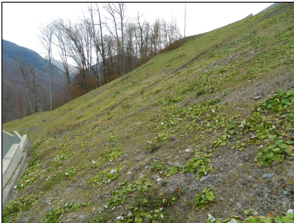
Фото 153. Спланированный склон. Развитие процессов эрозии. Т.Н. 699.
