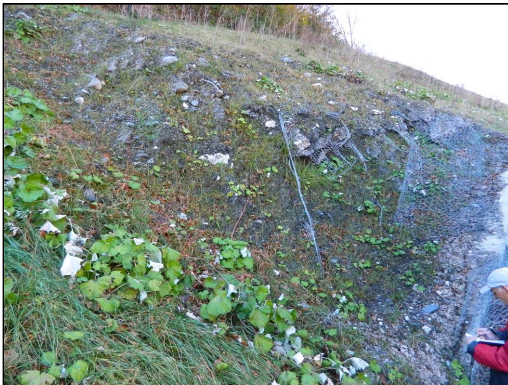
Фото 94. Оползневой стабилизированный склон. Т.Н.269.
