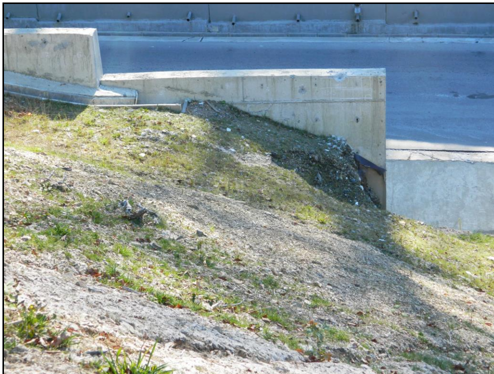
Фото 118. Спланированный склон. Развитие эрозионных процессов. Т.Н.443.
