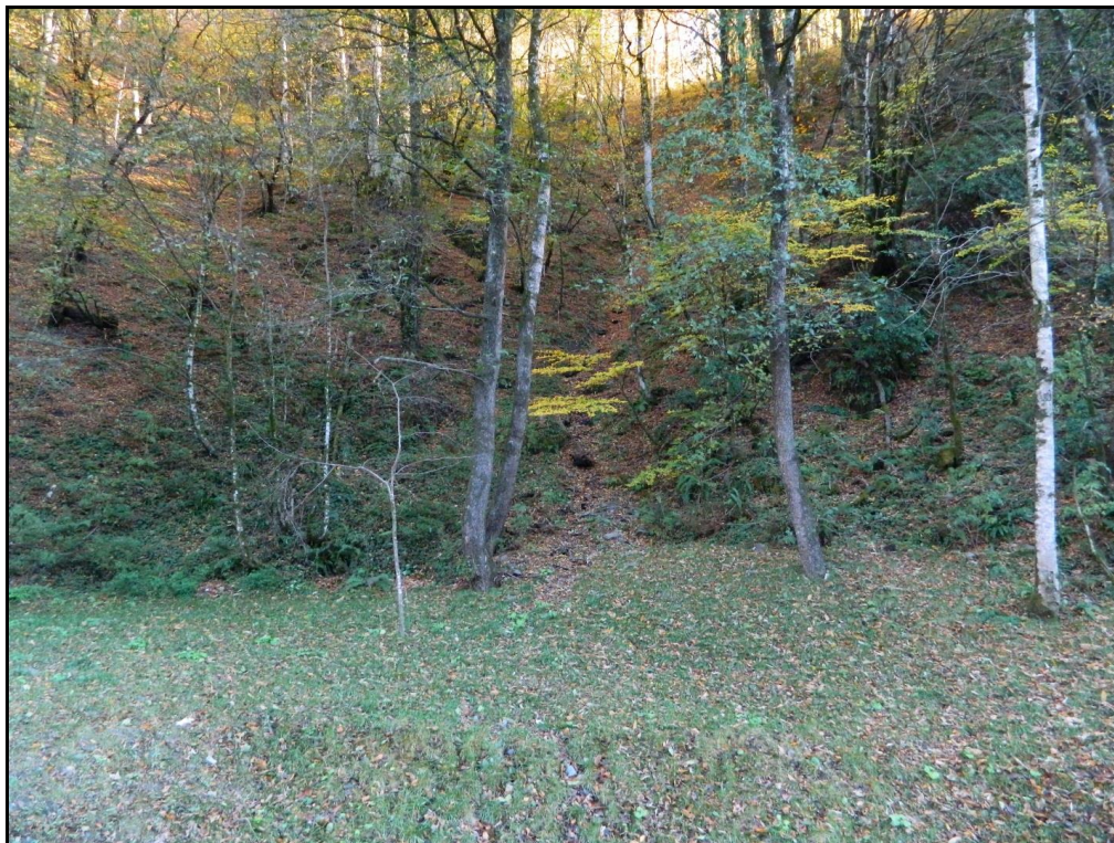
Фото 28. Оползневой уступ. Т.Н.31.
