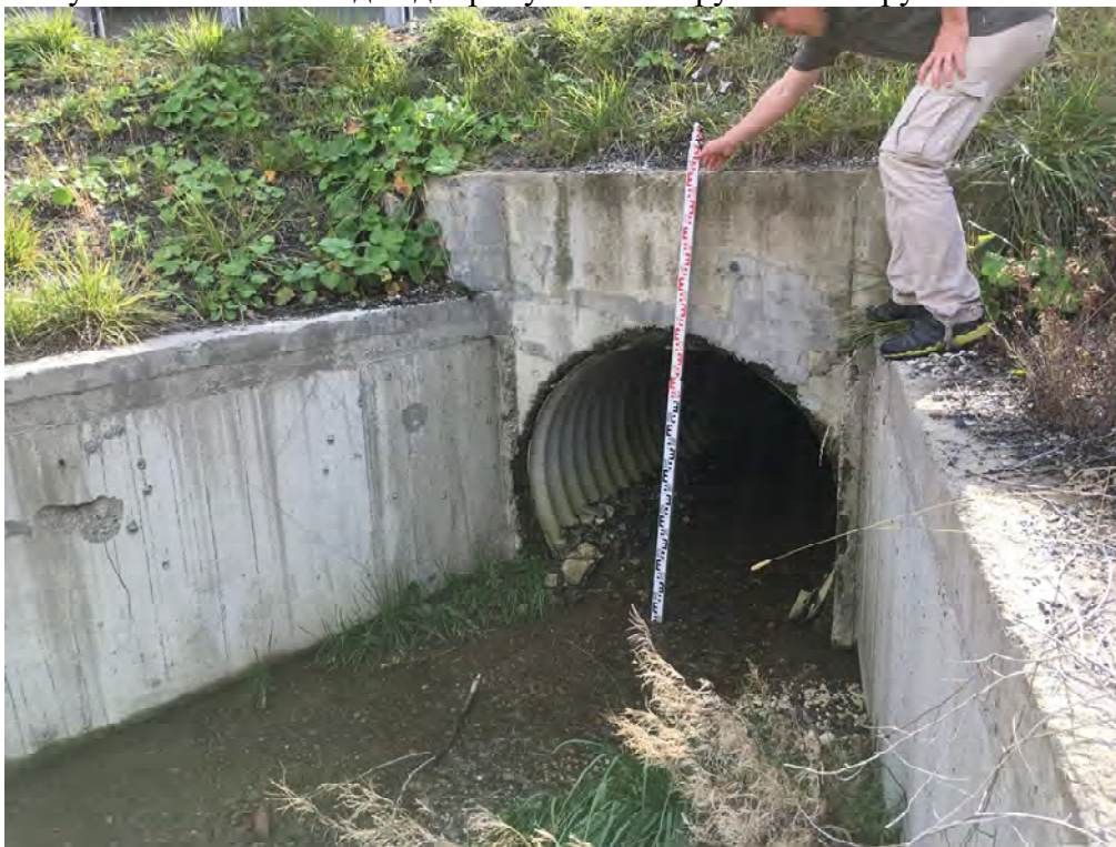
Рисунок 4.4.36 - Водовыпуск с подгорной части дороги ручья б/н №15 в створе №25
