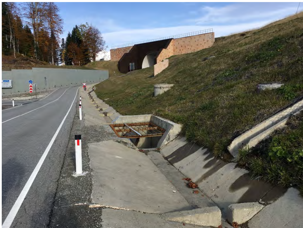
Рисунок 4.4.63 - Водоприемник с нагорной части дороги в створе №46 ручья б/н №30
