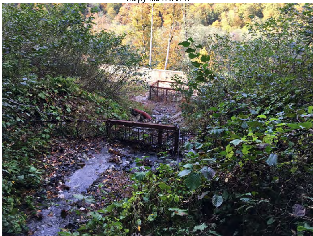
Рисунок 4.4.17. Защитная решетка выше водоприемника ручья б/н №8
