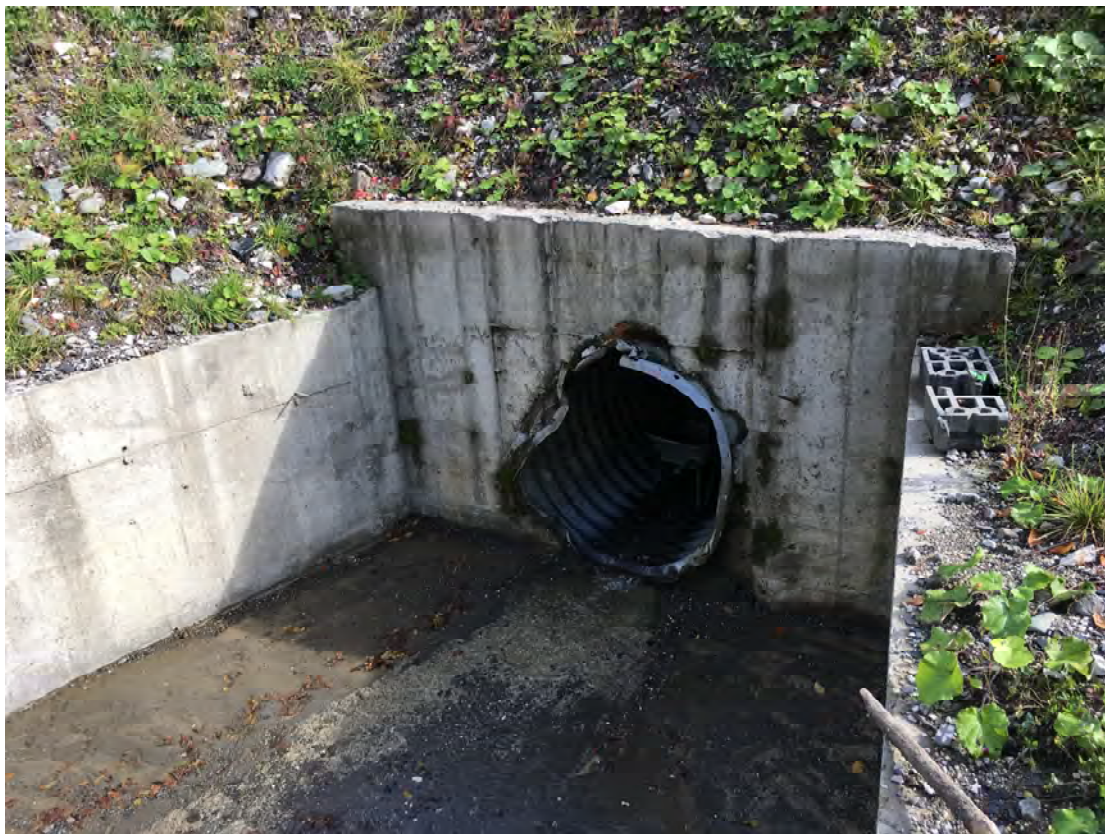
Рисунок 4.4.18. Водовыпуск с подгорной части дороги в створе №9
