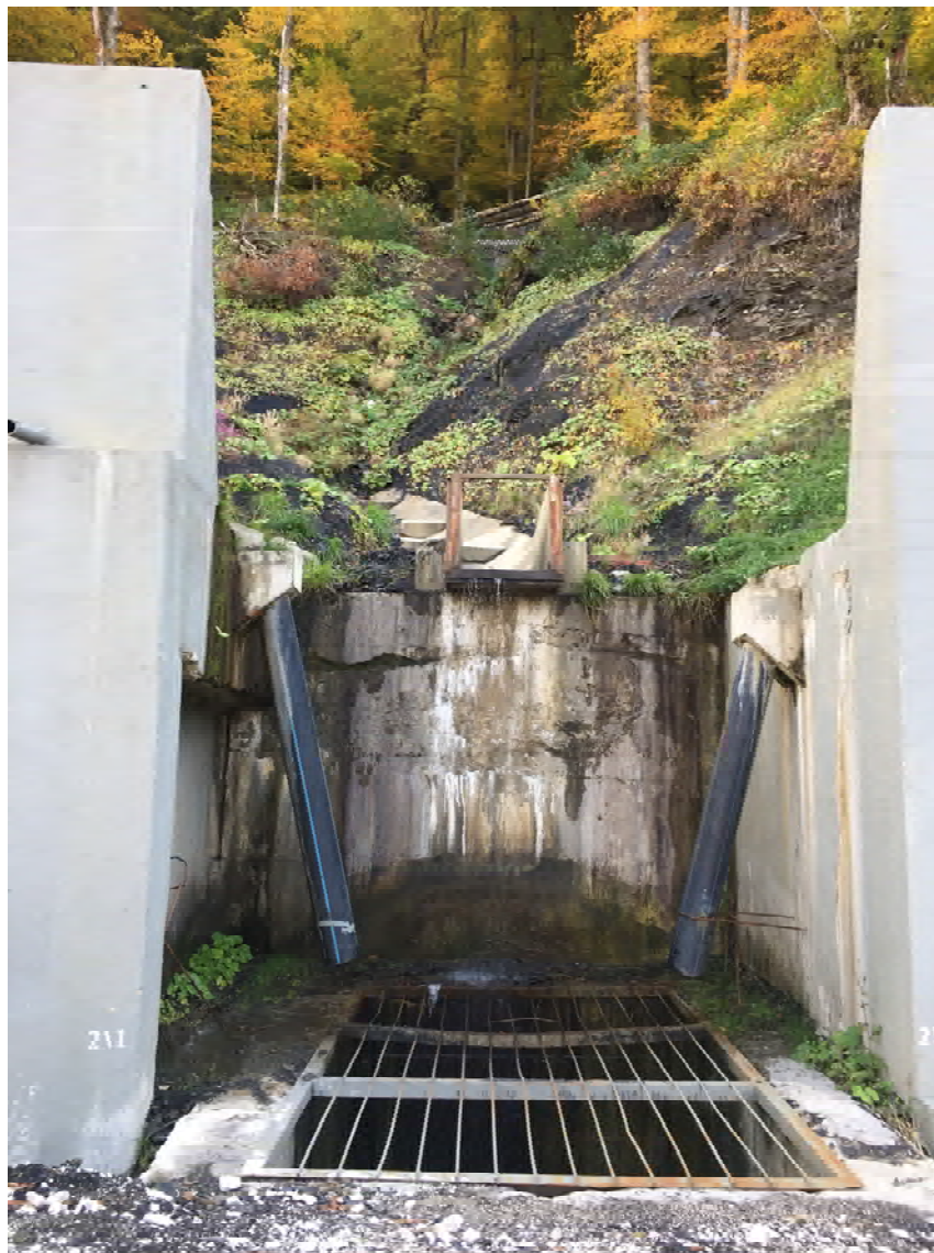
Рисунок 4.4.47 - Водоприемник с нагорной части дороги ручья б/н №21 в створе №34
