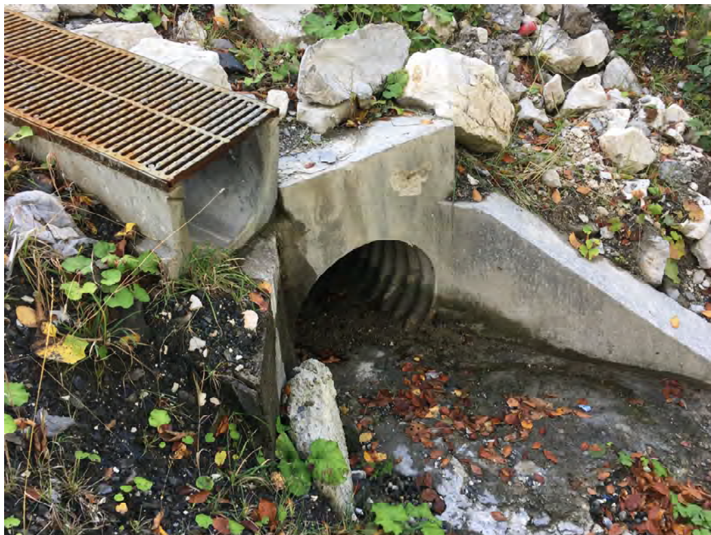
Рисунок 4.4.34 - Водовыпуск с подгорной части дороги в створе №19
