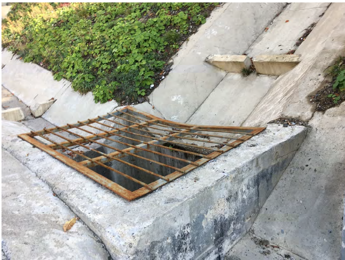
Рисунок 4.4.58 - Водоприемник с нагорной части дороги ручья б/н №24 в створе 40
