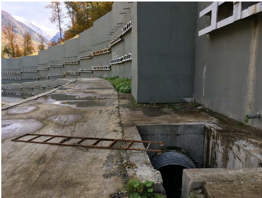
Рисунок 4.4.40 - Водоприемник с нагорной части дороги ручья б/н №16 в створе №24
