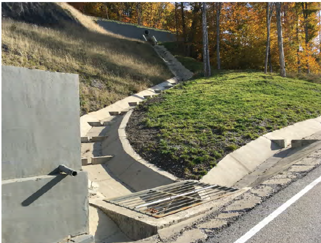
Рисунок 4.4.52 - Водоприемник с нагорной части дороги в створе № 36. Сообщение створов №36 и 39 бетонным руслом.
