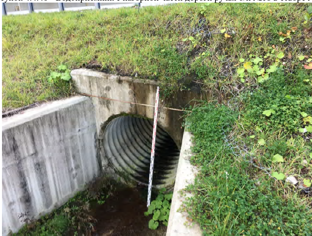
Рисунок 4.4.41 - Водовыпуск с подгорной части дороги ручья б/н №16 в створе №24
