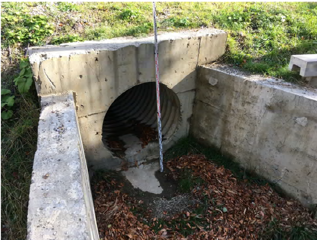
Рисунок 4.4.53 - Водовыпуск с подгорной части дороги ручья б/н №22 в створе №36
