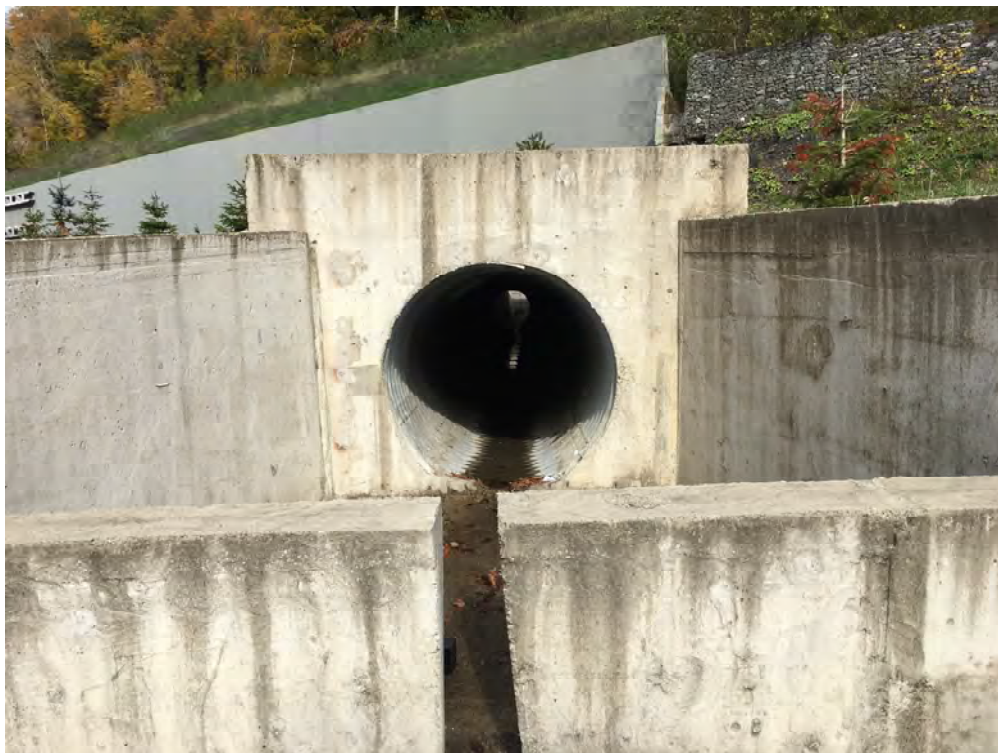
Рисунок 4.4.9 - Водовыпуск ручья б/н №5 со стороны русловой части р. Лаура.
