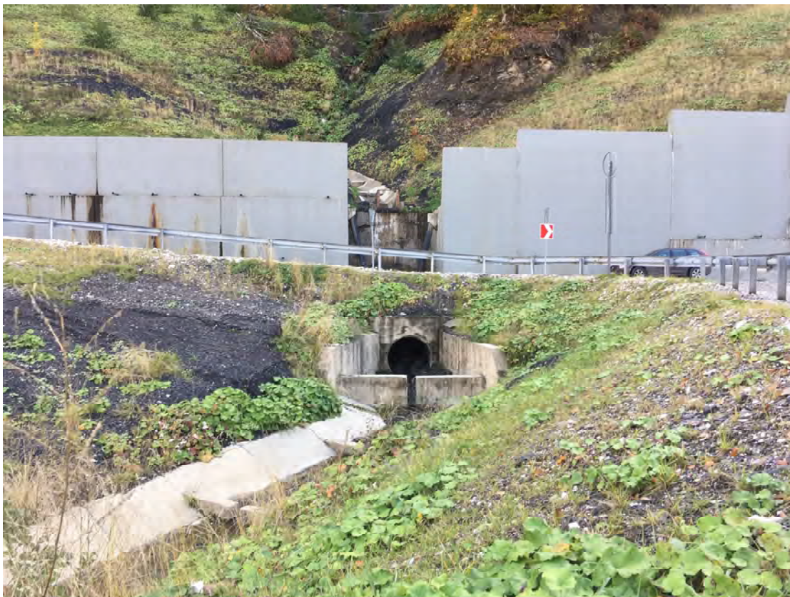
Рисунок 4.4.50 - Водовыпуск с подгорной части дороги ручья б/н №21 в створе №34
