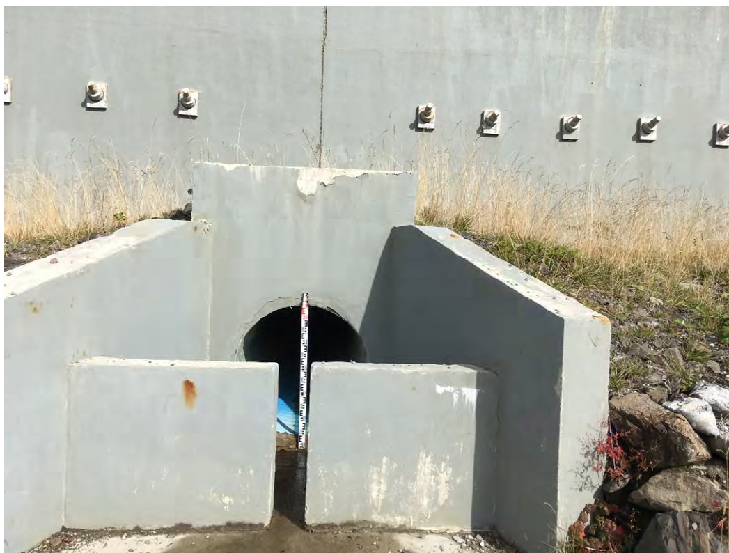
Рисунок 4.4.64 - Водовыпуск с нагорной части дороги в створе №47 ручья б/н №31
