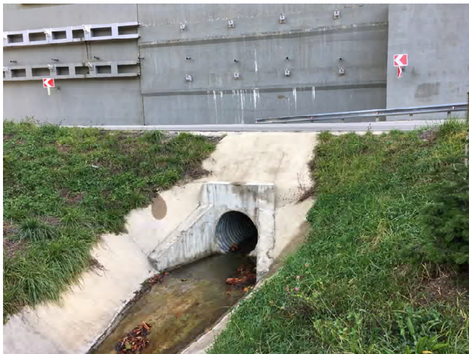
Рисунок 4.4.31 - Водовыпуск с подгорной части дороги ручья б/н №13 в створе №17
