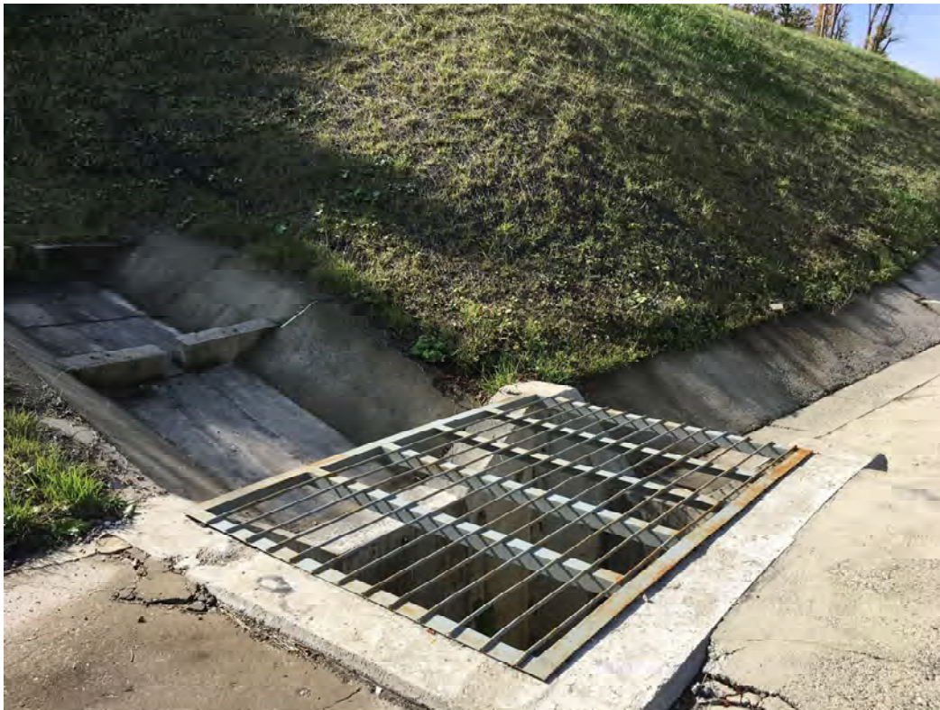
Рисунок 4.4.42 - Водоприемник с нагорной части дороги ручья б/н №16 в створе №30
