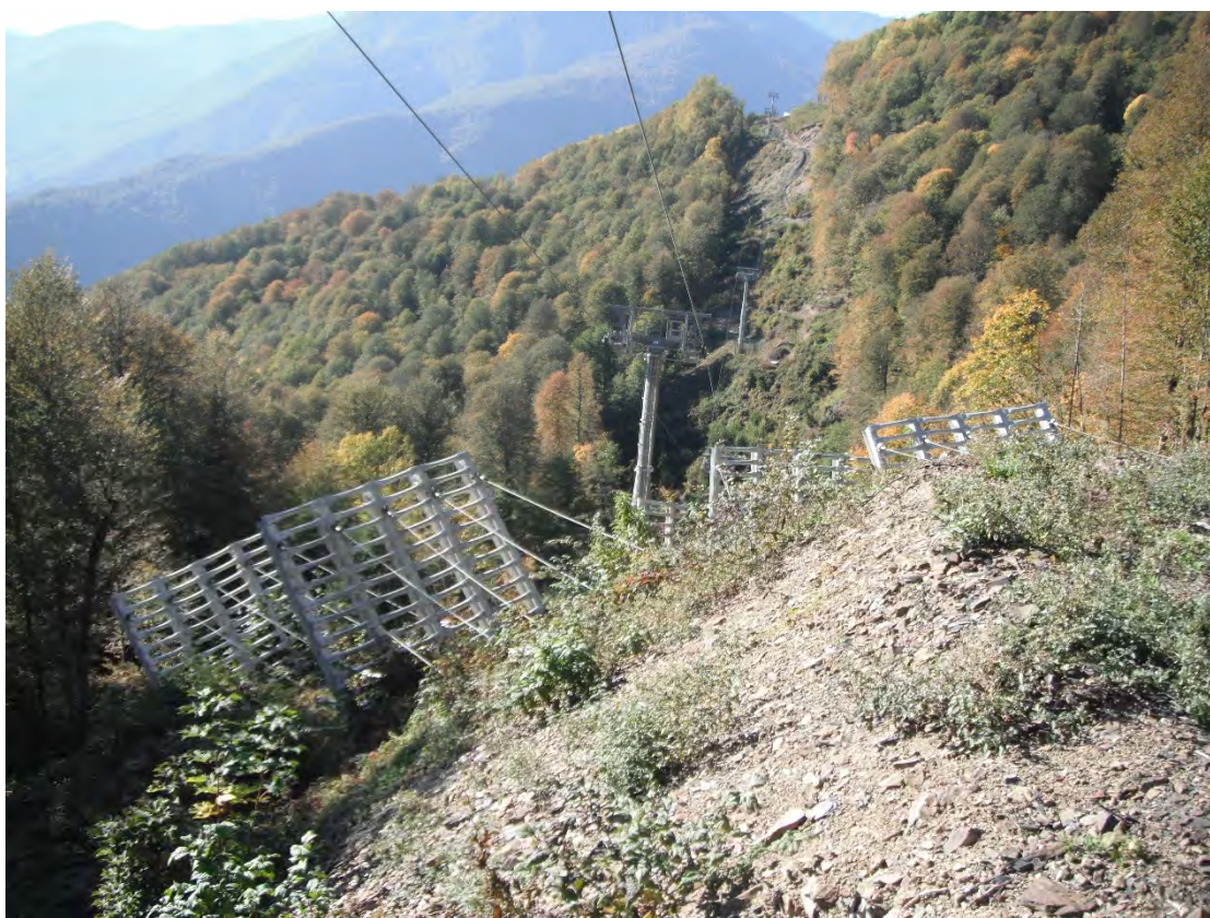
Рис. 6.72. Застроенный снегоудерживающими щитами лавинный очаг, угрожавший опоре 17.
