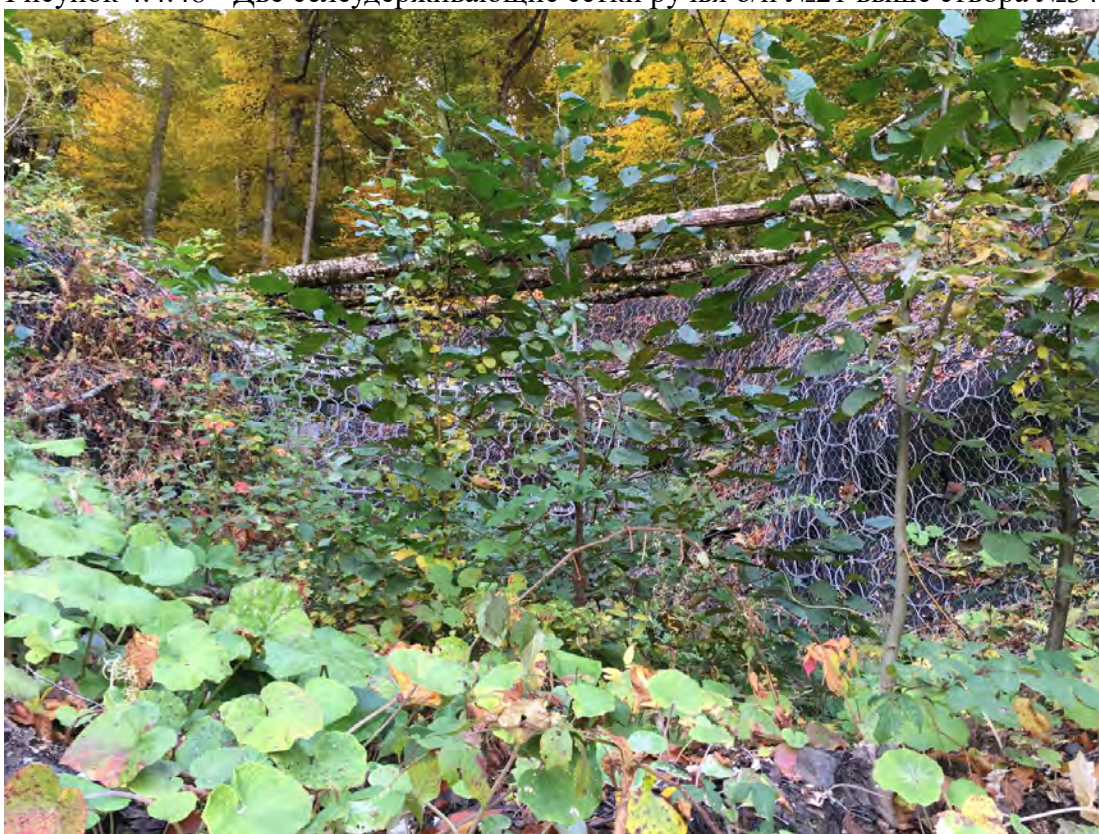
Рисунок 4.4.49 - Селеудерживающая сетка ручья б/н №21, расположенная выше по течению от створа №34
