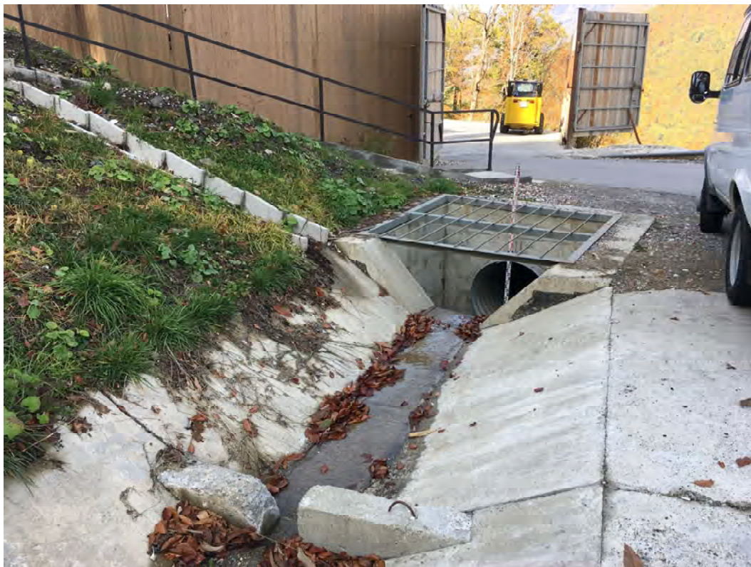
Рисунок 4.4.37 - Водоприемник с нагорной части дороги ручья б/н №15 в створе №31
