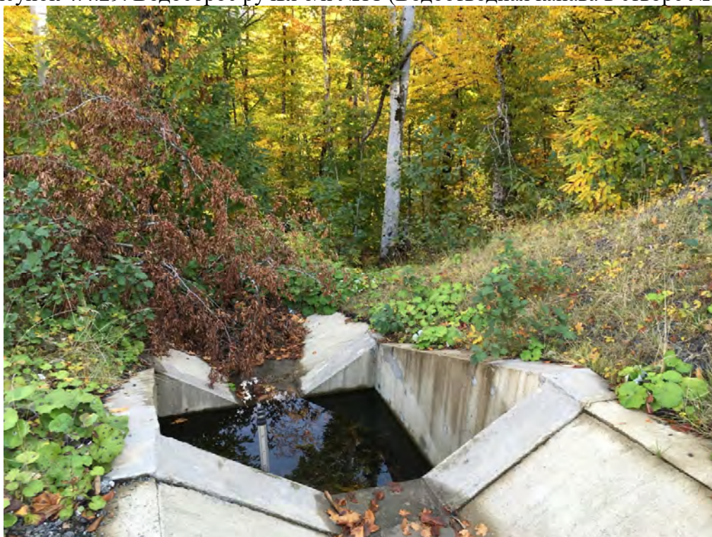
Рисунок 4.4.30. Водосброс ручья б/н №12 (Водоотводная канава в створе №13)
