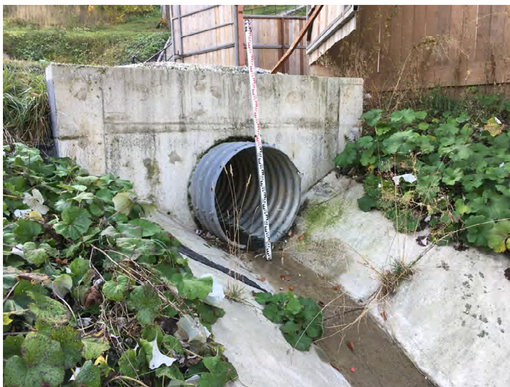
Рисунок 4.4.38 - Водовыпуск с подгорной части дороги в створе №31
