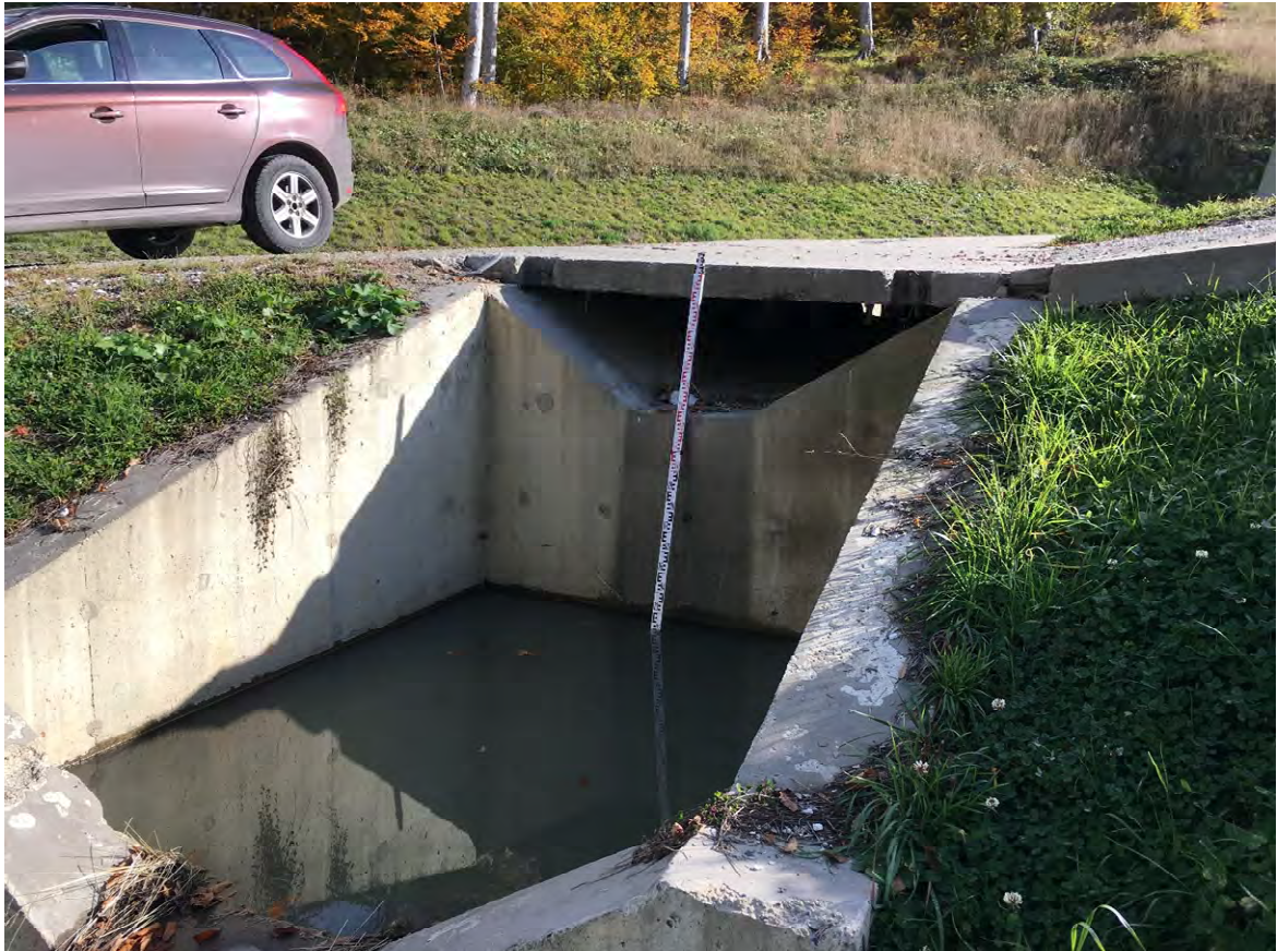
Рисунок 4.4.57. Водоотводное сооружение с подгорной части дороги в створе №37
