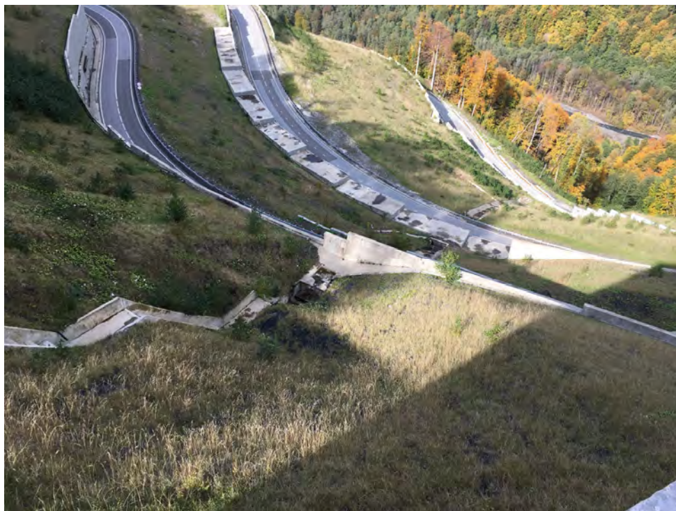
Рисунок 4.4.35 - Каскад водопропускных сооружений по ручью б/н №15
