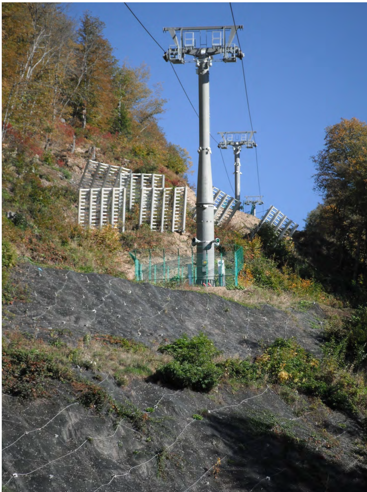
Рис. 6.73. Расположение снегоудерживающих щитов над опорой 17.
