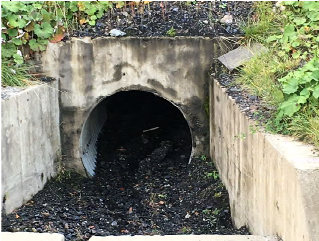
Рисунок 4.4.51 - Водовыпуск с подгорной части дороги крупным планом со следами селевых отложений ручья б/н №21 в створе №34
