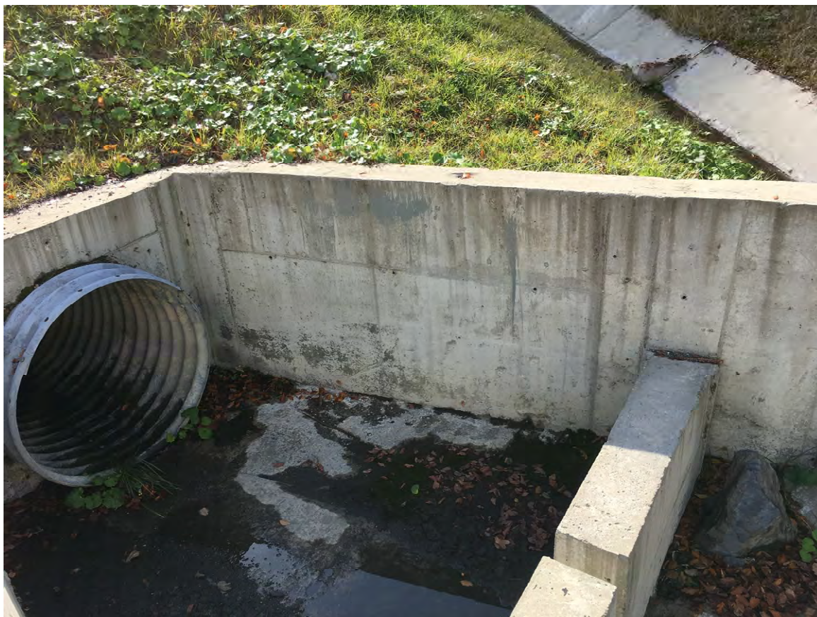
Рисунок 4.4.26 - Водовыпуск с подгорной части дороги в створе №26
