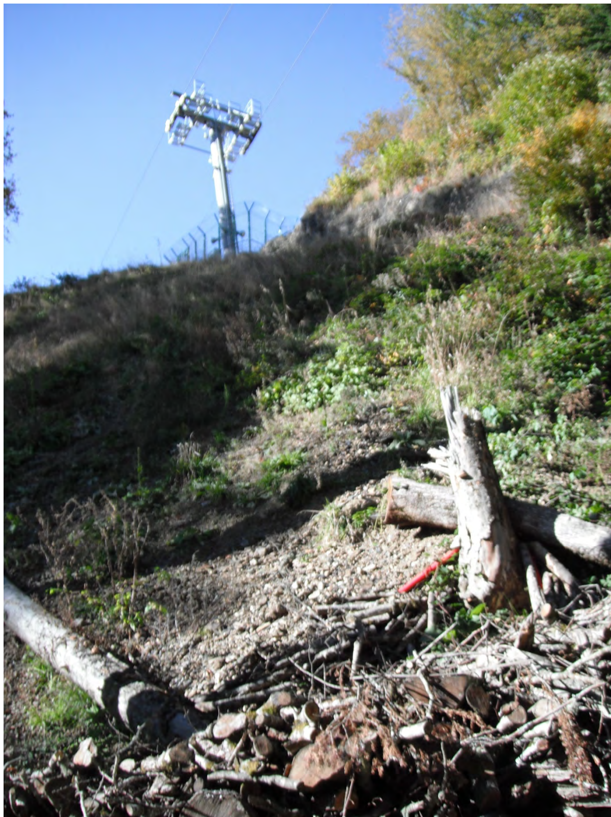
Рис. 6.78. Склон лавинного очага 18 под опорой канатной дороги 19.
