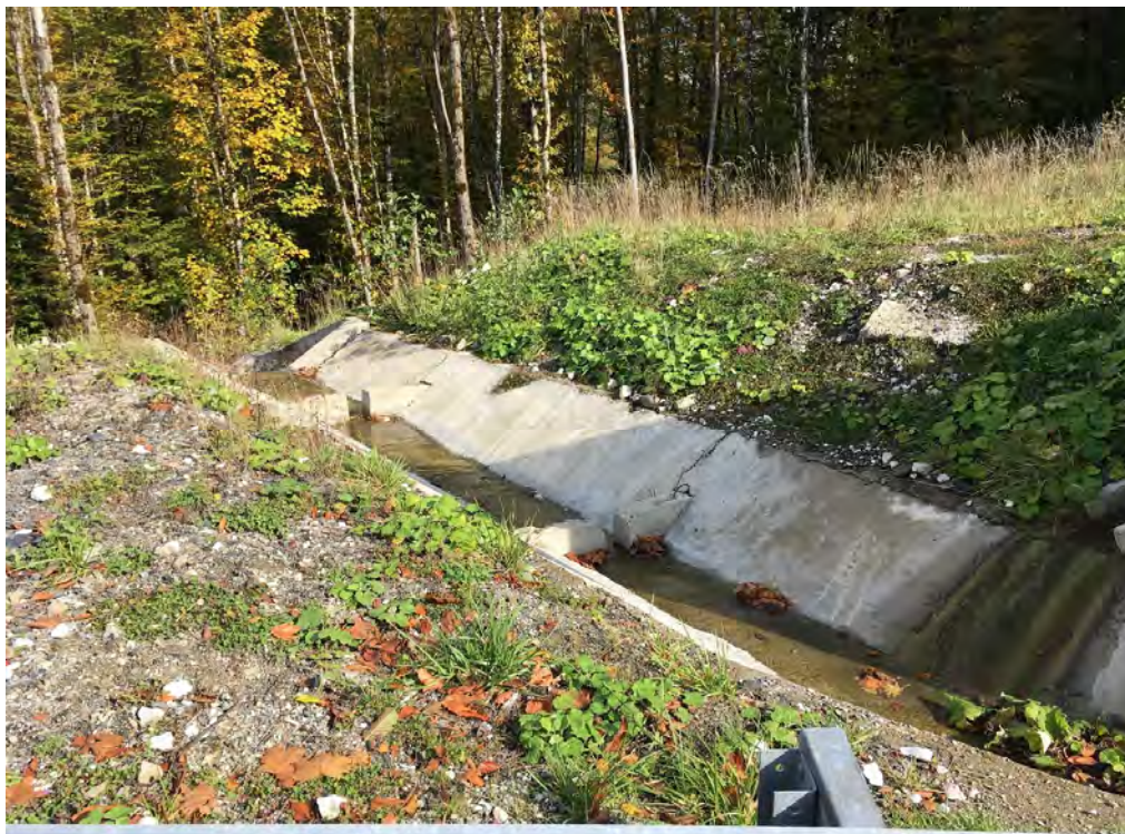
Рисунок 4.4.29. Водосброс ручья б/н №11 (Водоотводная канава в створе №12)
