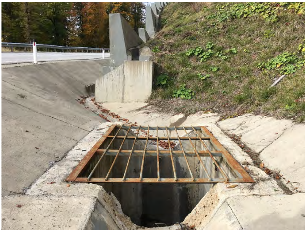
Рисунок 4.4.55 - Водоприемник с нагорной части дороги ручья б/н № 23 в створе №37
