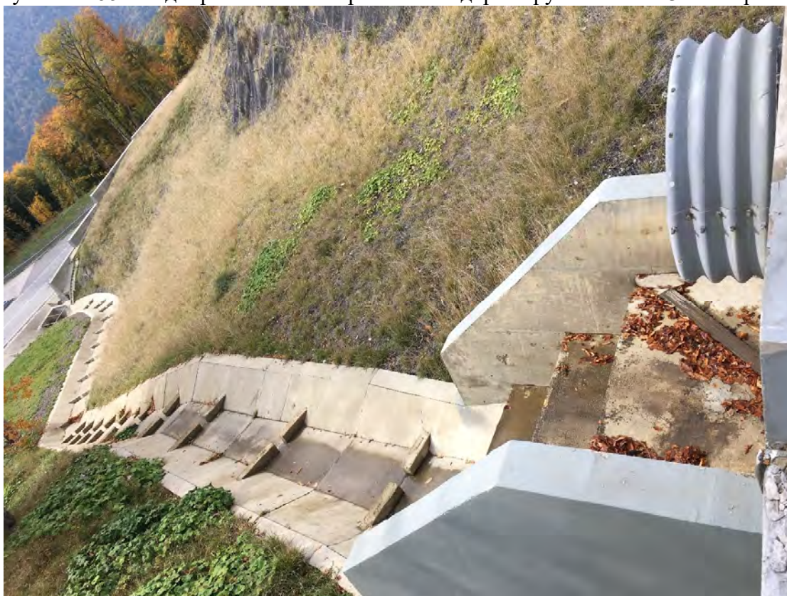
Рисунок 4.4.56 - Водовыпуск ручья б/н №23 от створа №38 к створу №37
