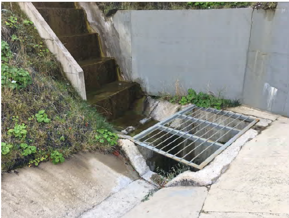
Рисунок 4.4.38 - Водоприемник с нагорной части дороги ручья б/н №16 в створе №21
