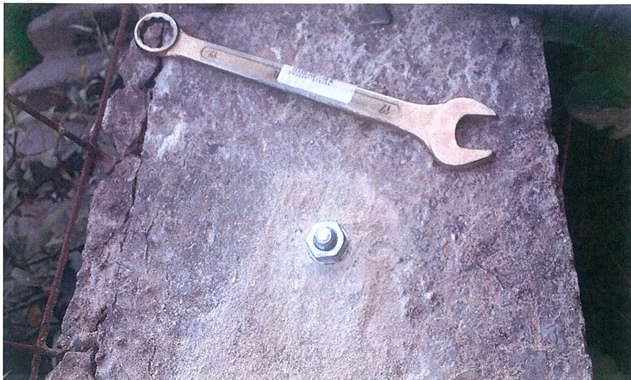
Рисунок 4. Деформационная марки в виде анкерного болта
