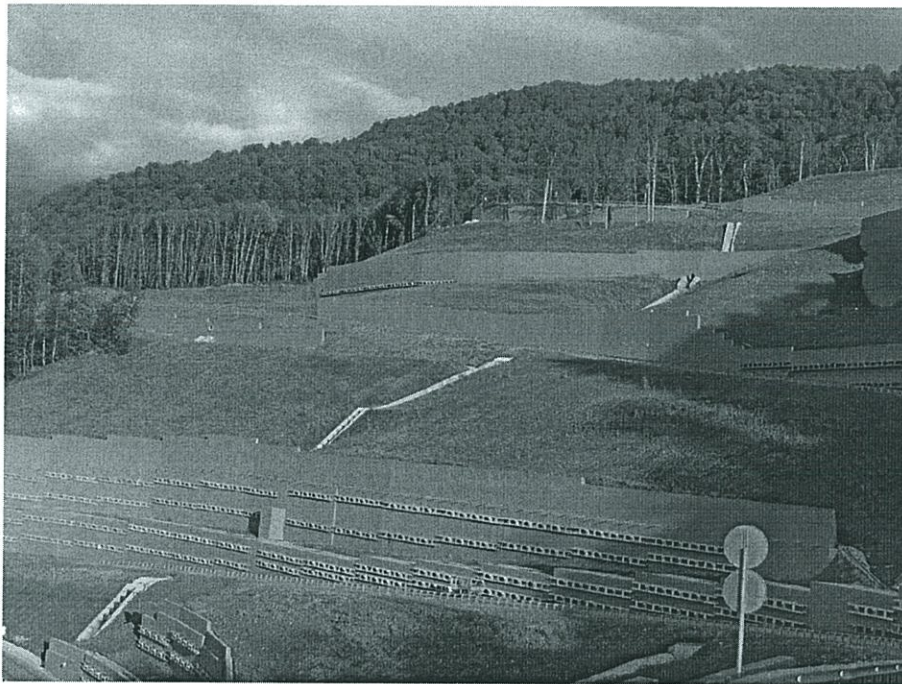
Рисунок 4 - Система искусственных русел ручья на автодороге СК6
