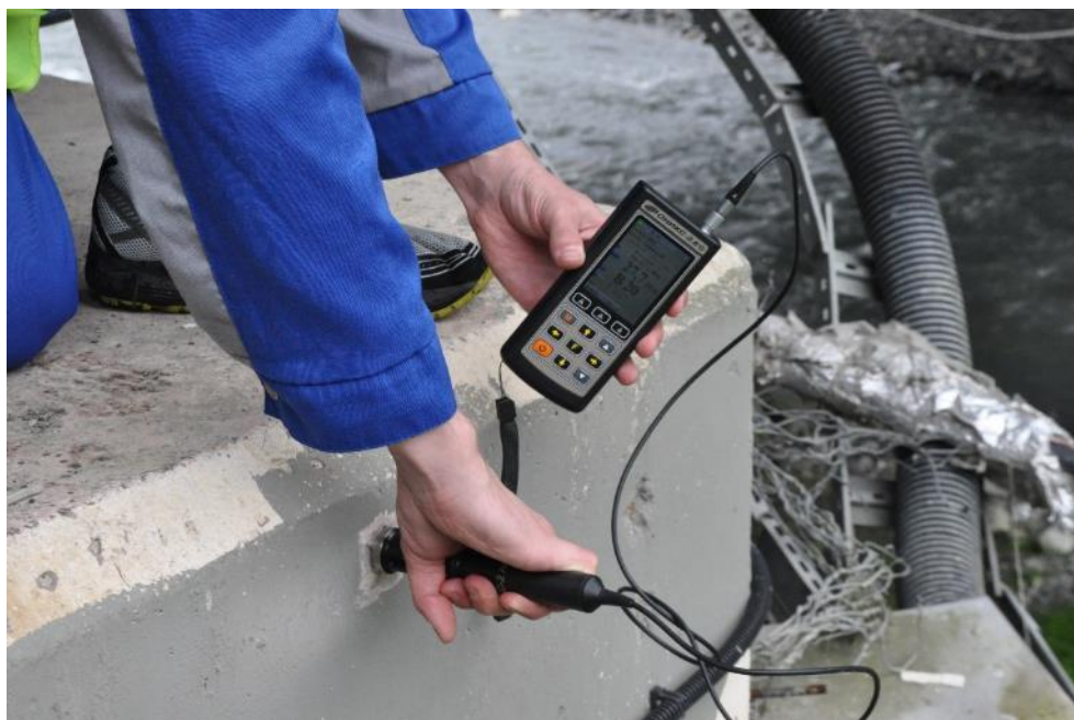
Рис. 4.1.3. Определение фактической поверхностной прочности бетона ригеля опоры №1 моста, справа (у балки Б-3 пролетного строения) с использованием измерителя прочности строительных материалов «ОНИКС-2.5»
