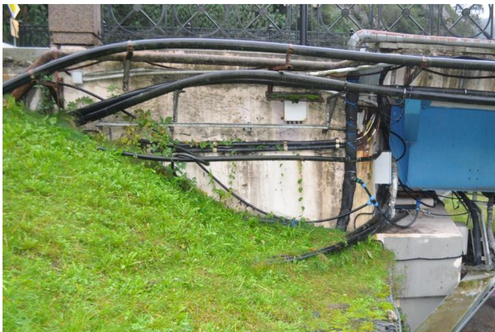
Рис. 1.10. Ригель и открылок крайней опоры №1 мостового сооружения (вид справа). Фото 23.09.2021г.
