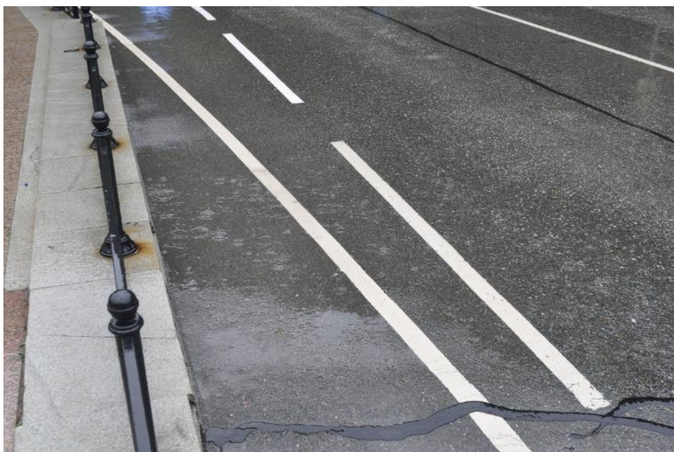
Рис. 3.6.2. Застой воды (лужа) на проезжей части подхода №2 к мосту в пределах полосы безопасности, справа. Фото 23.09.2021г.
