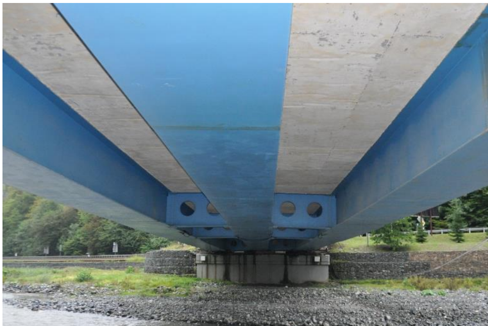
Рис. 1.7. Сталежелезобетонное пролетное строение моста. Вид снизу, со стороны крайней опоры №1. Фото 23.09.2021г.
