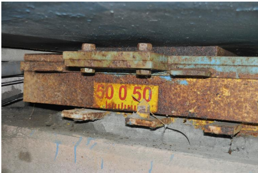
Рис. 3.3.5. Предельное продольное смещение балансира опорной части под балкой Б-2 на опоре №2. Фото 23.09.2021г.
