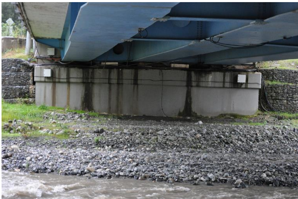
Рис. 1.9. Вид на крайнюю опору №2 мостового сооружения со стороны опоры №1. Фото 23.09.2021г.
