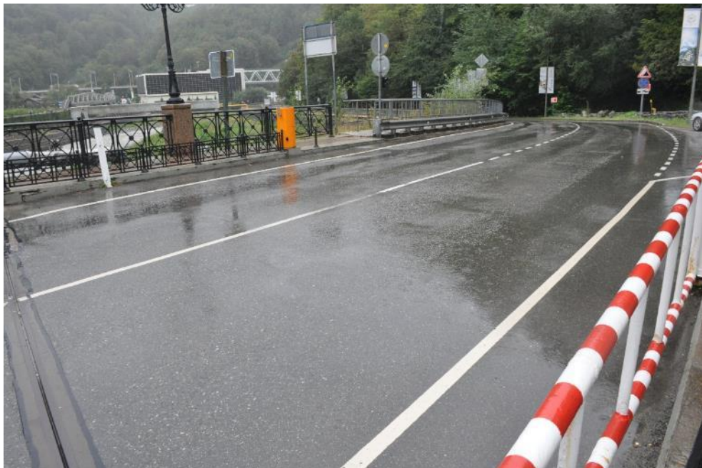
Рис. 1.6. Вид на проезжую часть подхода №2 к мостовому сооружению (вид в сторону с. Эсто-Садок). Фото 23.09.2021г.
