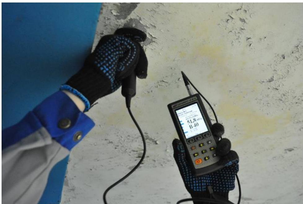
Рис. 4.1.1. Определение фактической поверхностной прочности бетона консоли плиты пролетного строения у балки Б-3 моста над крайней опорой №1 с использованием измерителя прочности строительных материалов «ОНИКС-2.5»
