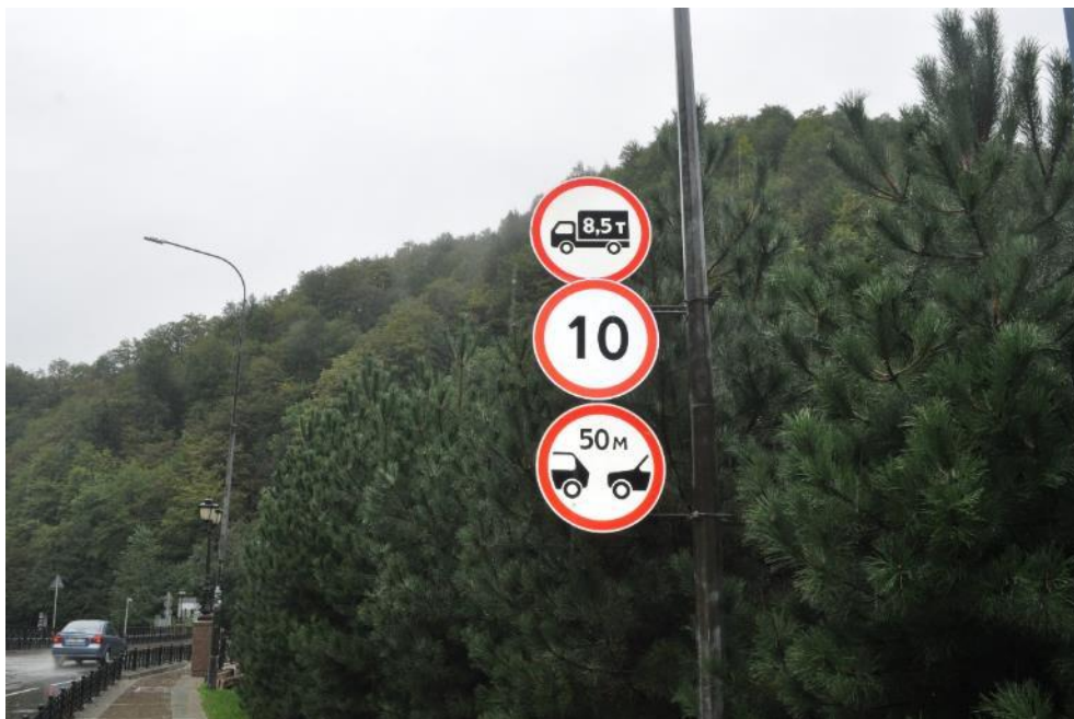
Рис. 1.13. Дорожные знаки 3.4 «Движение грузовых автомобилей массой более 8,5 т запрещено», 3.24 «Ограничение максимальной скорости – 10 км/ч» и 3.16 «Ограничение минимальной дистанции – 50 м» на подходе №1 к мостовому сооружению. Фото 23.09.2021г.
