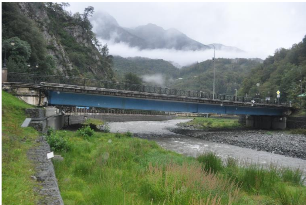
Рис. 1.1. Общий вид моста через реку Ачипсе слева, со стороны крайней опоры №2 Фото 23.09.2021г.
