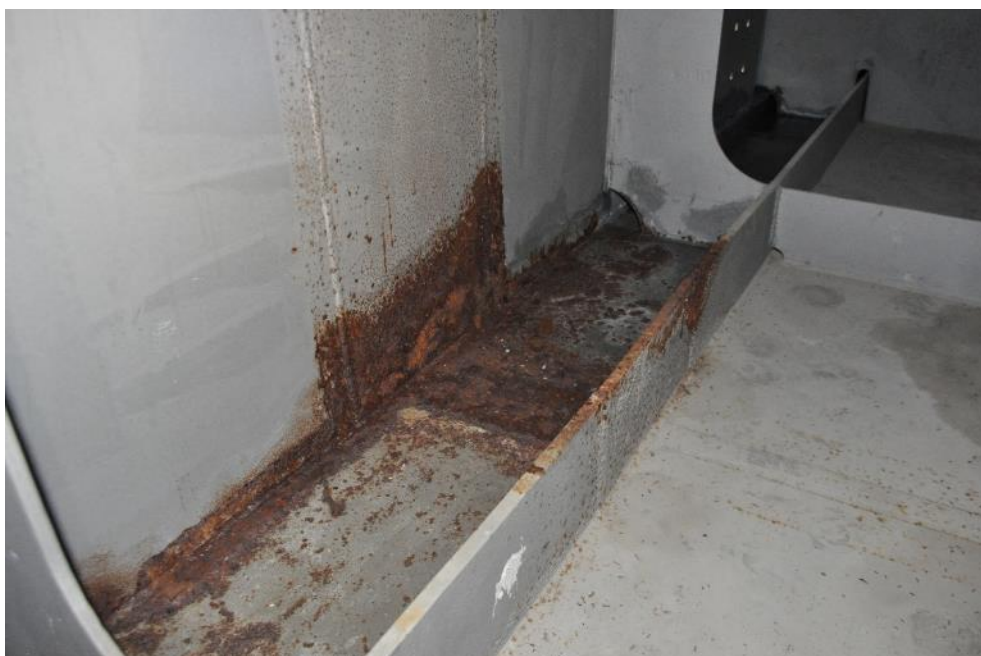
Рис. 3.2.14. Слоистая коррозия металла нижнего пояса и стенки главной балки Б-3 в зоне сварных стыков. Фото 23.09.2021г.
