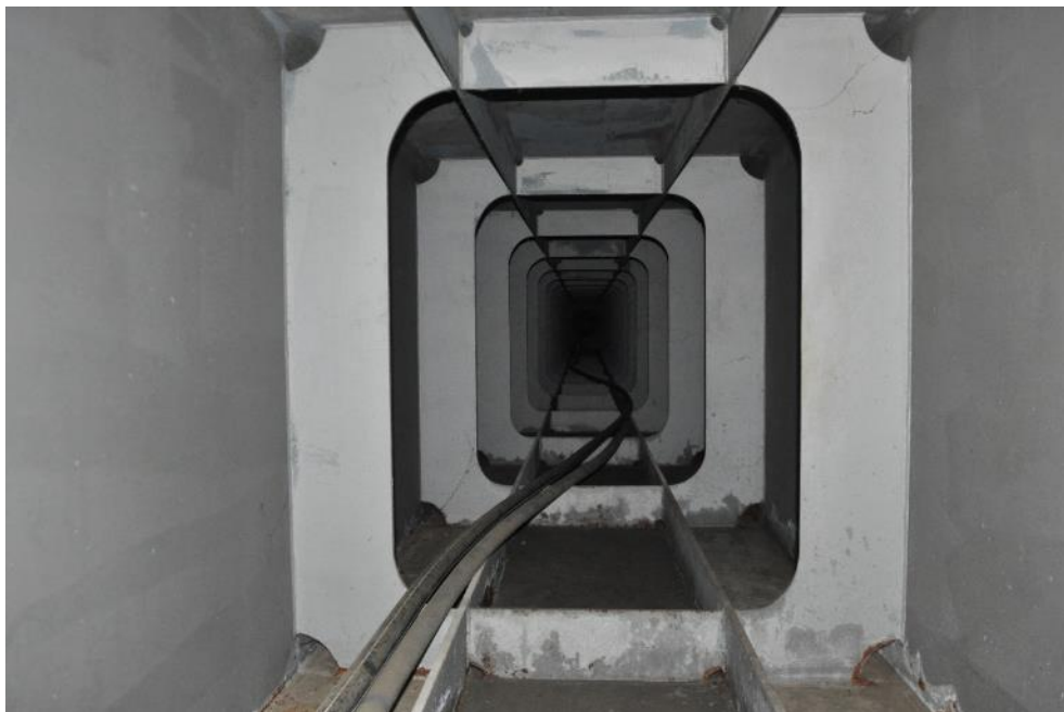
Рис. 1.8. Балка коробчатого сечения Б-3 сталежелезобетонного пролетного строения моста. Фото 23.09.2021г.
