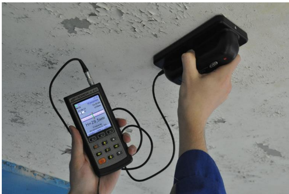
Рис. 4.2.1. Определение толщины защитного слоя бетона плиты пролетного строения ультразвуковым методом с использованием измерителя защитного слоя материалов «ПОИСК-2.6»
