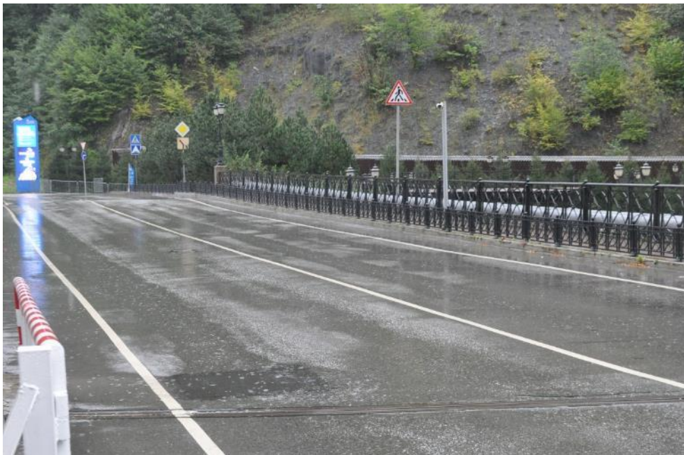
Рис. 3.1.4. Колейность асфальтобетонного покрытия на всей длине мостового сооружения глубиной 1... ..3 см Фото 23.09.2021г.
