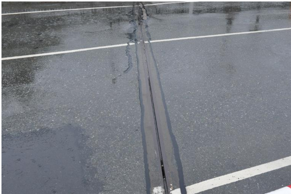
Рис. 1.4. Деформационный шов заполненного типа с резиновым компенсатором, однопрофильный (Betoflex-80), над крайней опорой №2 мостового сооружения. Вид справа. Фото 23.09.2021г.
