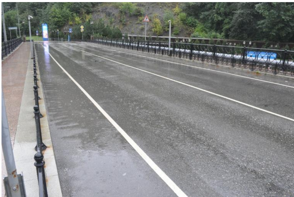
Рис. 1.2. Вид на проезжую часть моста со стороны крайней опоры №2 (в сторону горно-туристического центра ПАО «Газпром»). На проезжей части мостового сооружения на момент обследования нанесена горизонтальная дорожная разметка 1.1 и 1.2. Фото 23.09.2021г.
